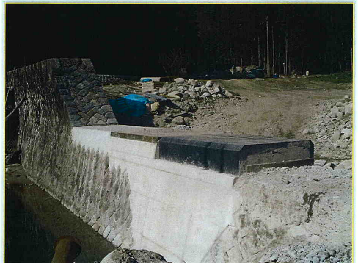
試験施工状況②(施工完了)
