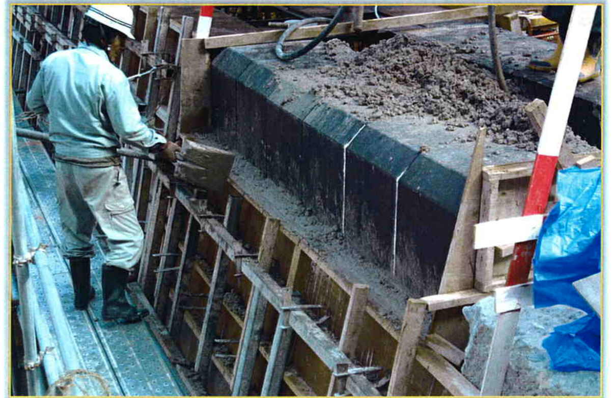
試験施工状況①(コンクリート打設状況)
